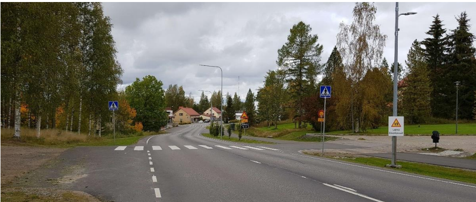
Petäjaveden taajama sijaitsee Jämsänveden koillispuolella. Uuden kirkon tienoilla rakentaminen tukeutuu maastonmuotoja myötäilevään Kirkkotiehen.
