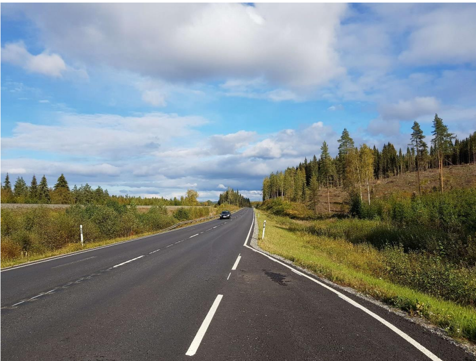
Selännealueella Pitkälänvuoren kohdalla valtatieta 23 rajaavat metsäalueet. Valtatie 23 vierellä kulkee penkereellä rautatie. Tien eteläpuolella kohoaa Tervämäki.
